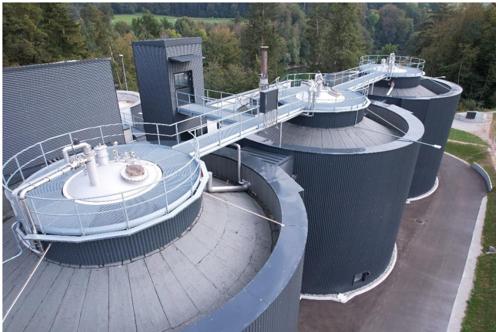
Traitement des boues - Nouveaux digesteurs de 1'500 m 3 chacun
